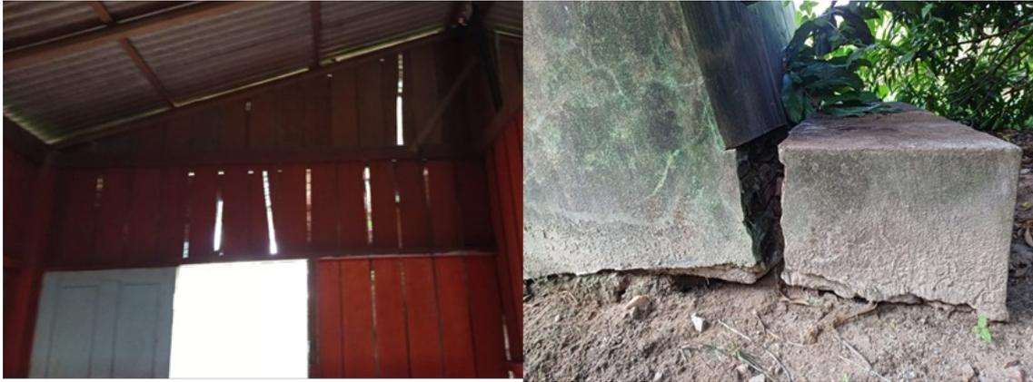
Figura 30. Frestas (à direita) e danos estruturais (à esquerda) das casas na Terra Indígena Paquiçamba.
